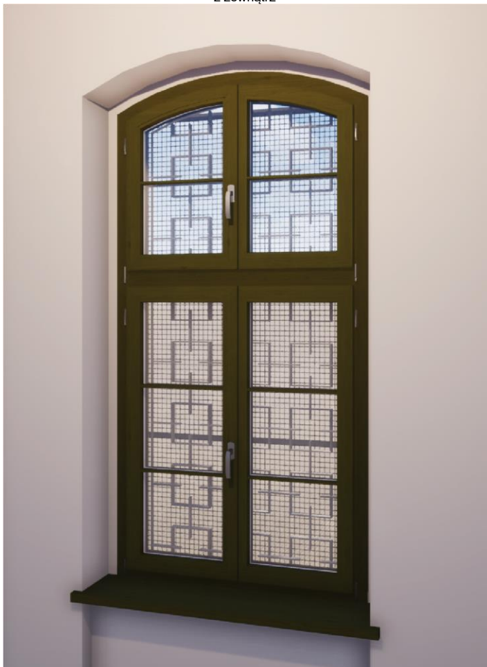
Okno O3 widok z pomieszczenia
