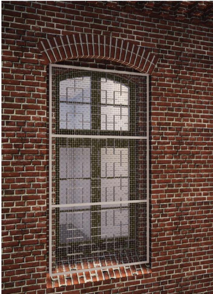
Okno O3 widok z zewnątrz
