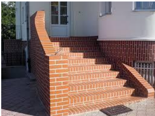
Sposób zakończenia policzków schodów zewnętrznych.
