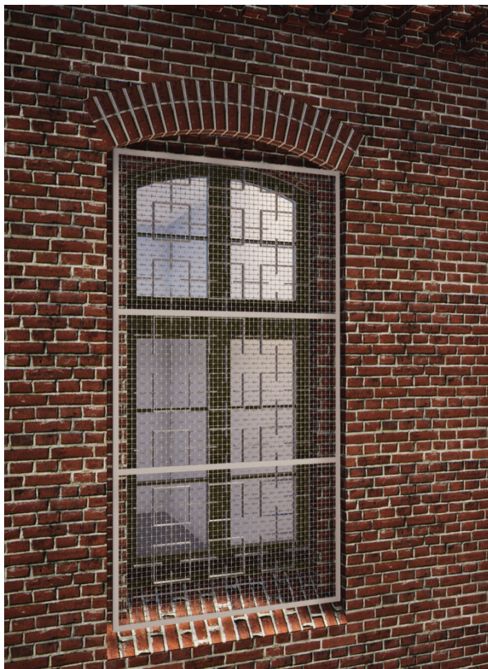
Okno O3 widok z zewnątrz
